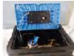
スマート水道メーターとは、遠隔で検針値等のデータを取得でき、指定された時間隔もしくは一定水量の使用ごとにデータ送信ができる水道メーターをいう。
