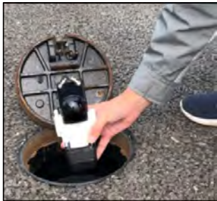
振動センサーを活用した水道管の漏水検知システム
