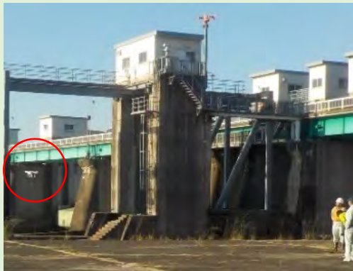
頭首工点検における UAV活用状況
