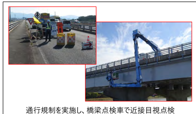
従来点検（H26～H30：1巡目点検）
