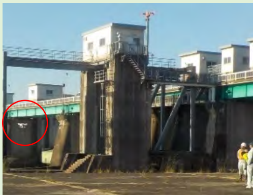
頭首工点検における UAV活用状況
