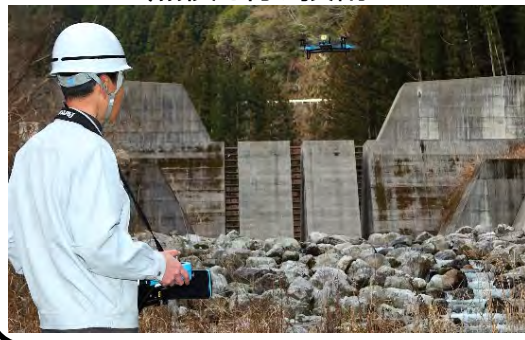
ドローンを活用して砂防施設の点検を行う技術
