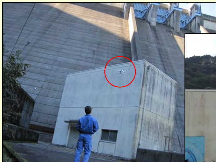
洪水放流管建屋及びダム堤体側面確認状況
