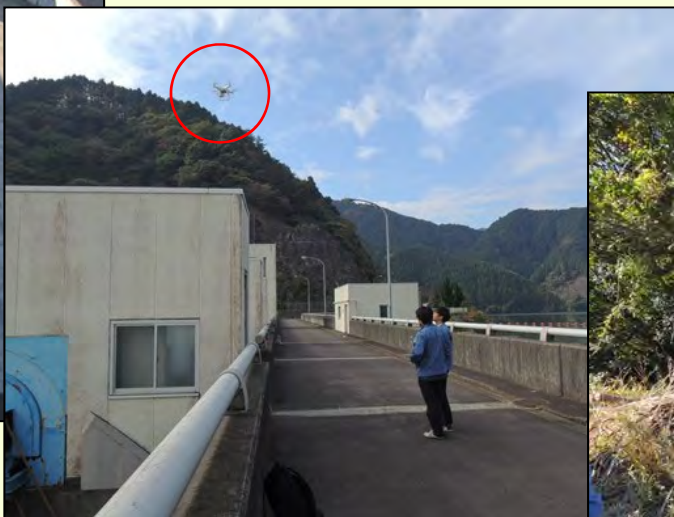
ダム堤体確認状況
