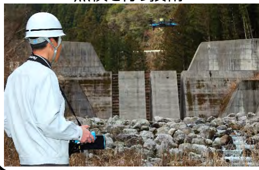
ドローンを活用して砂防施設の点検を行う技術
