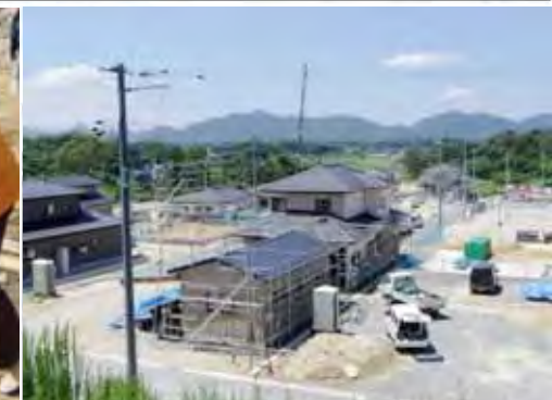
＜工事の状況(大戸浜地区)＞
