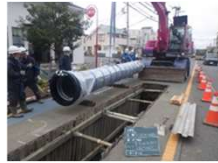
老朽管路の改修
