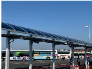
バス停の屋根に設置されたペロブスカイト太陽電池
