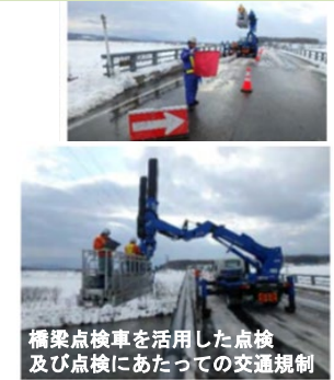
橋梁点検車による近接目視
