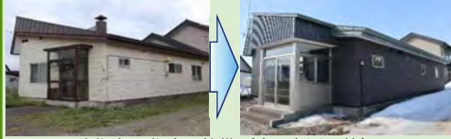
移住者用住宅の整備 (空き家活用等)
