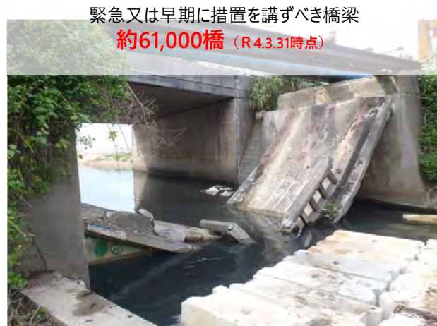
老朽化が原因で落橋した国内事例
