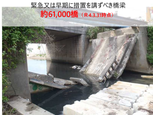
老朽化が原因で落橋した国内事例
