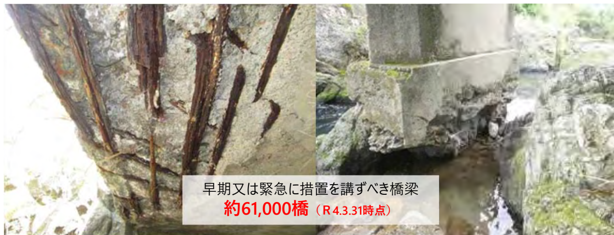
橋梁の裏側の鉄筋露出
