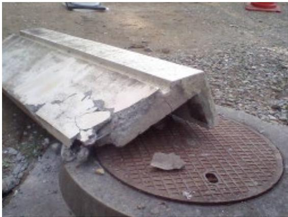
老朽化により落下した手すり
