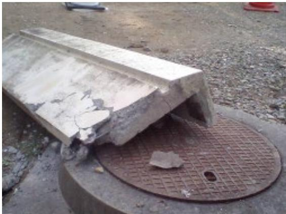
老朽化により落下した手すり
