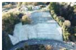
法面対策により緊急輸送道路の通行を確保 (神奈川県 国道20号)
