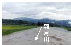
河道掘削等により浸水被害を防止 (鹿児島県 羽月川)
