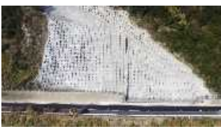
【道路の法面法粋工】
