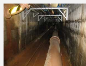
老朽化した秋田市八橋終末処理場
