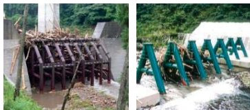
透過構造の砂防施設 河川内の流木捕捉工
