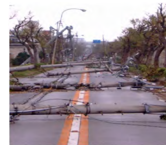
電柱の倒壊による道路閉塞
