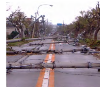
電柱の倒壊による道路閉塞
