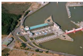
末端部河口で地区全体の排水を担当している新川河口排水機場 (昭和45年竣工、現在改修中)
