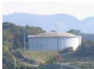
かん水の安定供給を可能とする調整水槽
