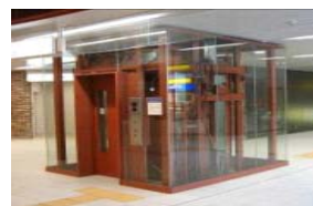
【エレベーター】
