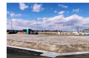
高台移転による宅地造成
