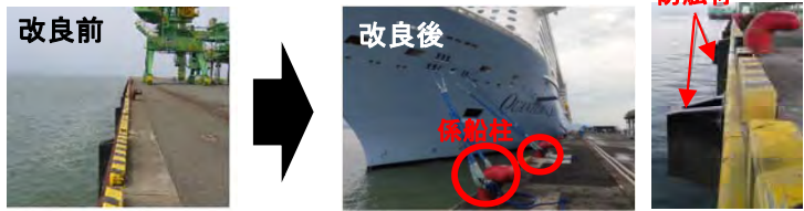
クルーズ船の寄港需要の急激な増加や船型の大型化への対応(既存岸壁の改良)
