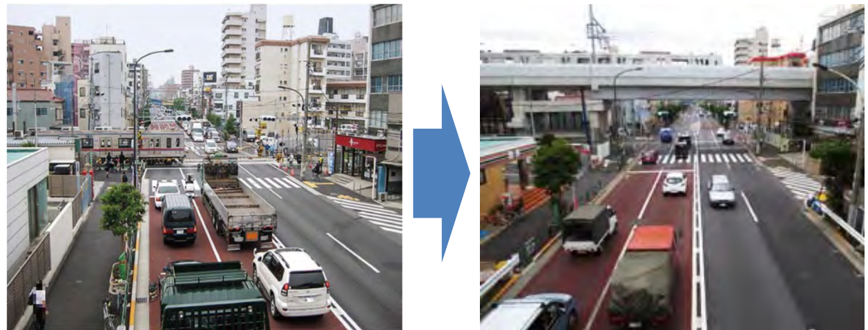
京成押上線(押上駅～八広駅間)連続立体交差事業(H27.8高架化)
