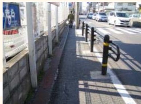
<防護柵の設置>
