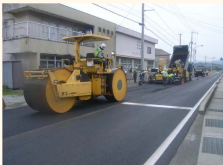
切削オーバーレイによる補修
