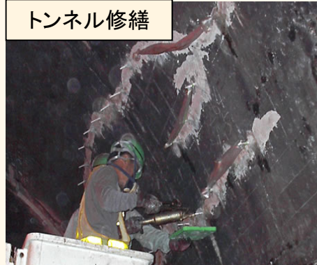
ひび割れ注入による補修
