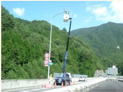
道路照明点検
