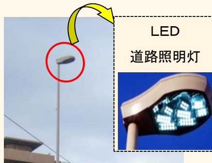
LED道路照明灯の整備
