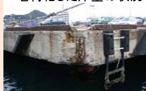
老朽化した岸壁の状況
