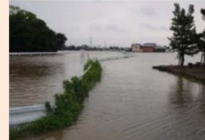
排水路の機能低下による湛水
