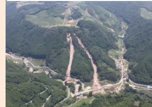
山腹崩壊の発生状況
