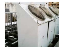
電気ヒートポンプ
