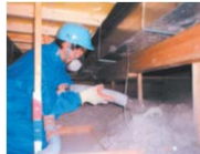
天井の断熱改修
