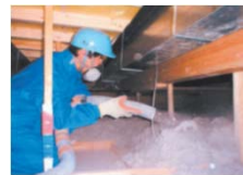
天井の断熱改修
