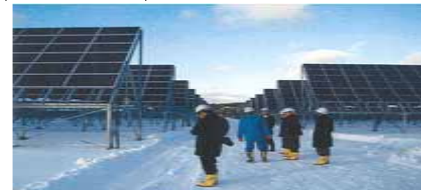
(太陽光パネル)
