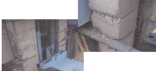
可動堰 (妙見堰) の被災状況 (新潟県中越沖地震)
