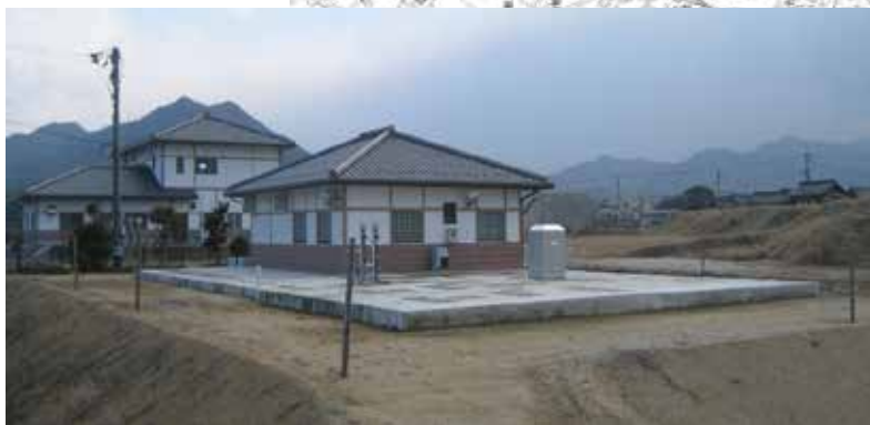
旧朝倉地区横に増設された処理施設(H28年度完成予定)
