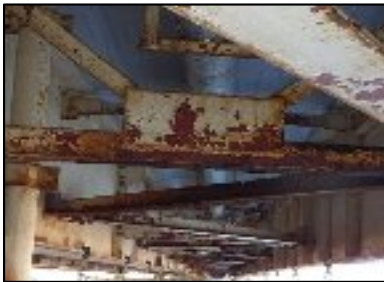
部材の腐食
