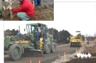
従来施工(丁張りによる施工)
