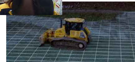
ICT建機による施工
