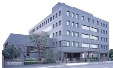
*東京都文京区 本駒込の日本医師会館
