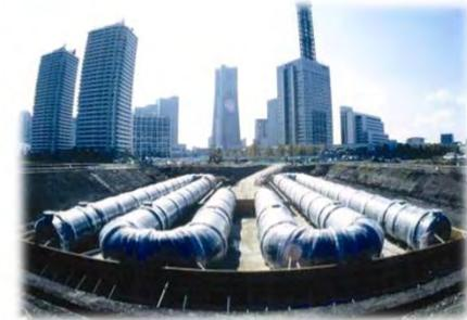
耐震型循環式地下貯水槽
