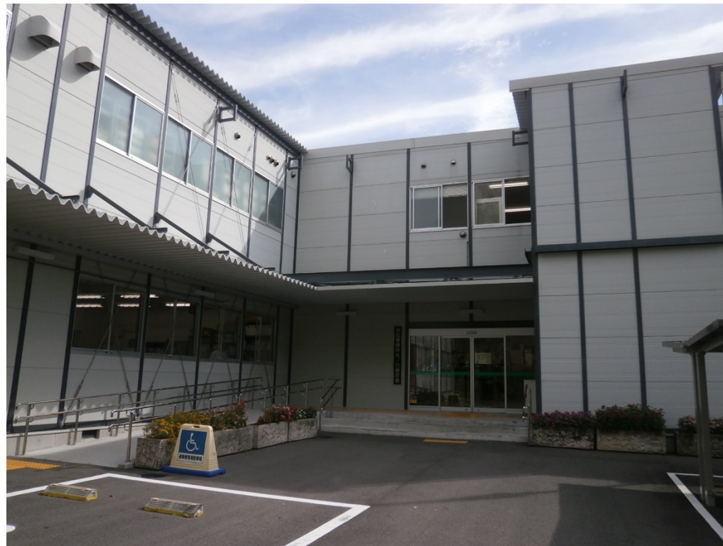
高知市役所中央窓口センター
