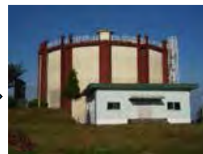
市町村受水タンク
