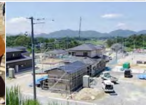
＜工事の状況(大戸浜地区)＞
