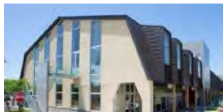
B街区 官民複合施設(オガールプラザ)
