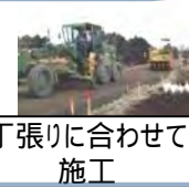
検測と施工を繰り返して整形
