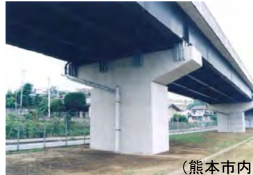
(熊本市内) 橋梁の耐震補強(国道3号 跨線部)
