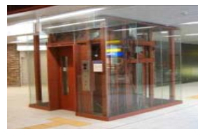
【エレベーター】
