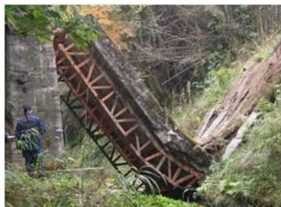
香川・徳島県境無名橋の落橋
