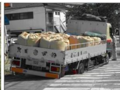
下水管路に起因した道路陥没
