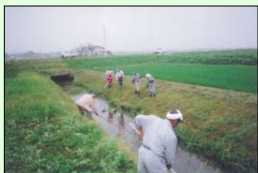
水路の泥上げ
