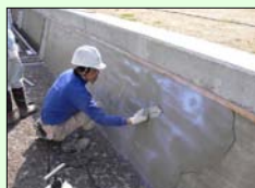
水路の補修・更新
